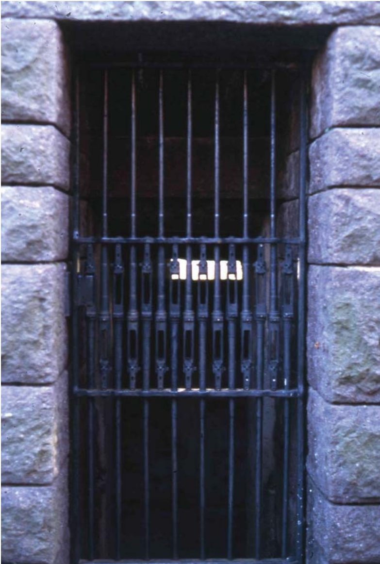
Abb. 5: Tür des überformten Bunkers (Foto: Christian Fuhrmeister, 1997)
